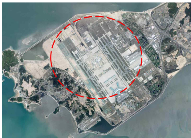
인천국제공항 잔여공유수면매립지 신규등록(6.8km 2 )
